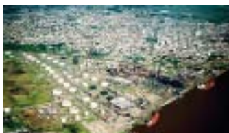
ExxonMobil - Refinería de Campana, Argentina
